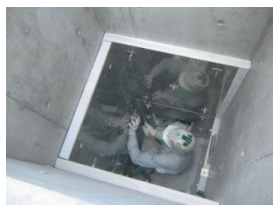
ライニング材直貼り
