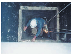
レンガ撤去中
